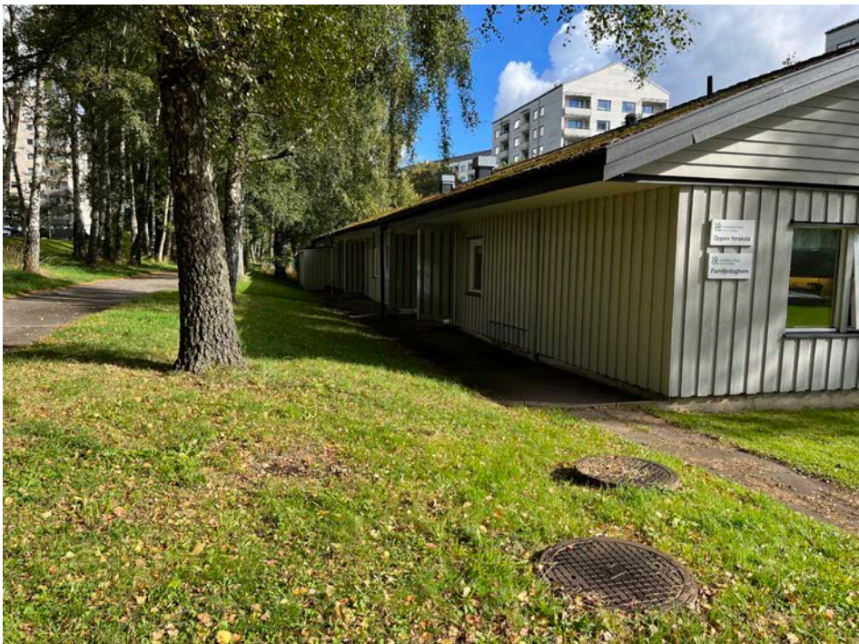
Förskolan som kommer att rivas. Möjlighet att minska klimatpåverkan genom att bibehålla betongplattan.
