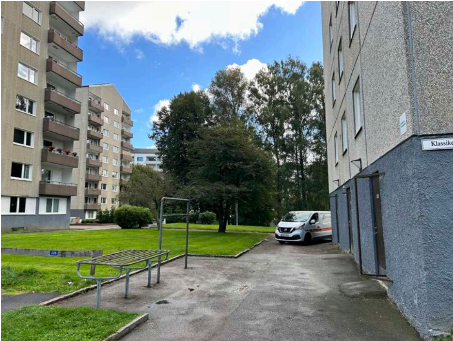
Utsatta ytor vid fasad
